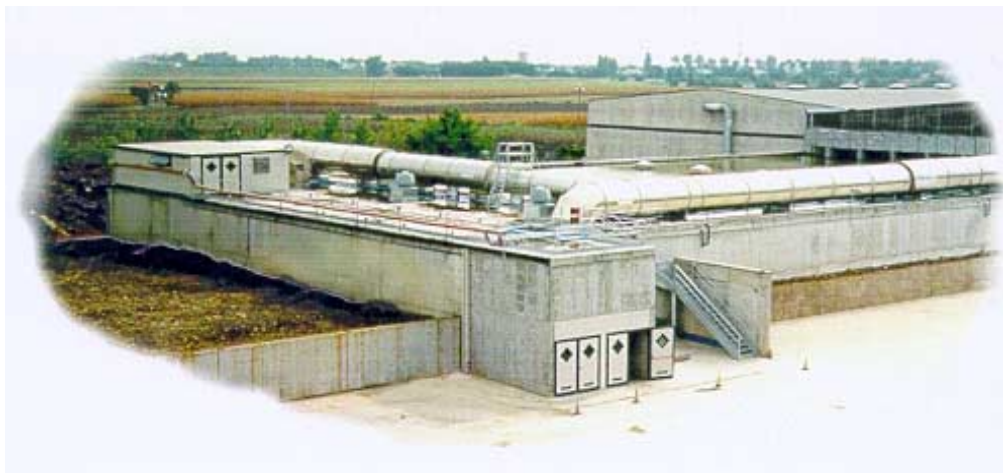
Figura 37 - Vista esterna della sezione di biossificazione accelerata dal lato biofiltro
